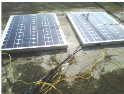
Gambar 3. Instalasi pengujian Modul surya.
