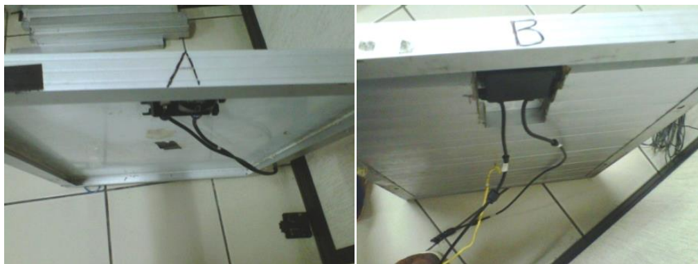
Gambar 4. Pemasangan PCM pada Modul surya.
