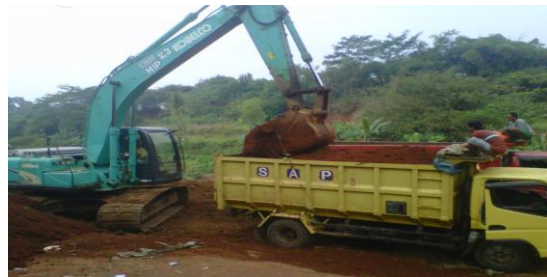
Gambar 3. Proses Pemindahan Tanah Galian ke Dump Truck
