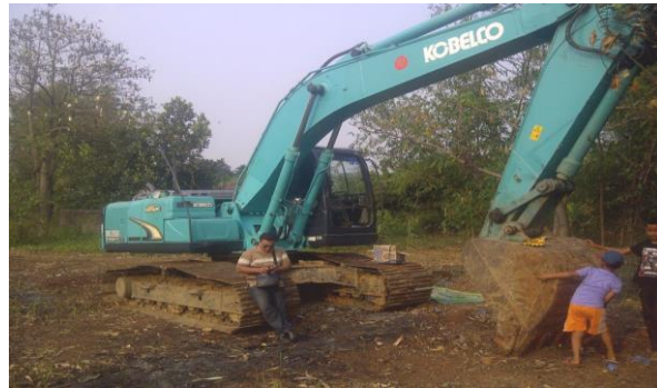
Gambar 2. Excavator pada Galian Tanah
