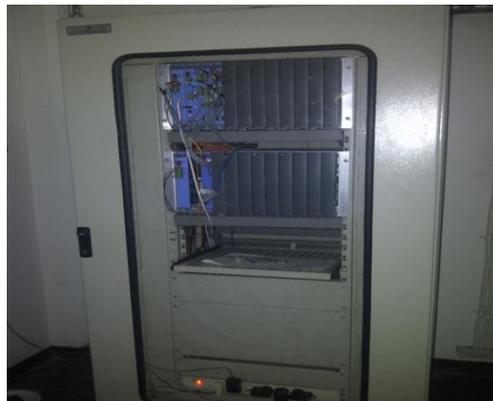
Gambar 14. RTU dengan Media Komunikasi Fiber optik
