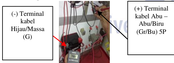
Gambar 29. Mengukur Tegangan Input Idle Air Temperature Sensor pada Terminal Kabel Warna Abu-Abu/Biru Konektor 5P Sensor Unit – Massa ( Didapatkan Tegangan Sebesar 5,02 V ).
