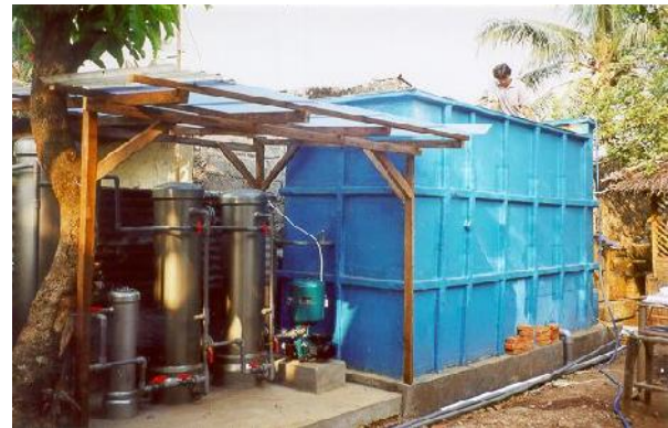
Gambar 8. Kontruksi IPAL pelapisan logam yang telah terpasang
