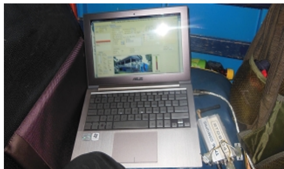
Gambar 18 : Pengujian Status Komunikasi Perangkat RTU di Masing-Masing Lokasi Pemasangan .
