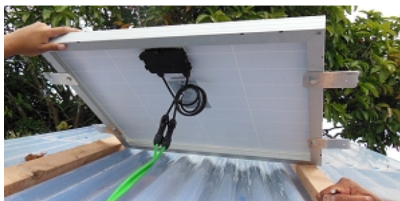
Gambar 15 : Pemasangan Solar Cell.
