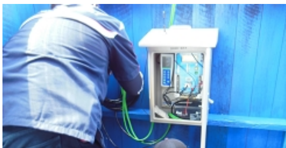
Gambar 16 : Pemasangan Box Panel dan Data Logger.
