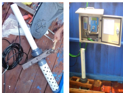
Gambar 17 : Pemasangan Sensor dan Casing Pelindung PVC.
