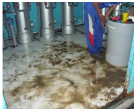
Gambar 12. Kondisi Ruang UNIT IPA RO yang Tampak Kotor.
