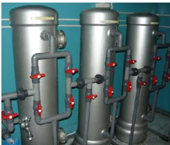
Gambar 5. Saringan Pasir Cepat, Iron Manganese Filter, dan Filter Karbon Aktif.
