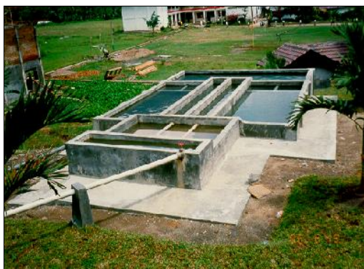
Gambar 5 : Unit Pengolahan Air Bersih Sarpalam dengan sistem arah aliran dari bawah ke atas ( Up Flow ) kapasitas 100 M 3 /hari. Lokasi : Pesantren Latansa, Lebak, Jawa Barat.
