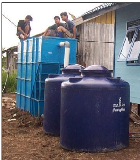
Gambar 12 : Bak pengendap yang berfungsi juga sebagai kontaktor udara kontaktor udara dan bak penampung.
