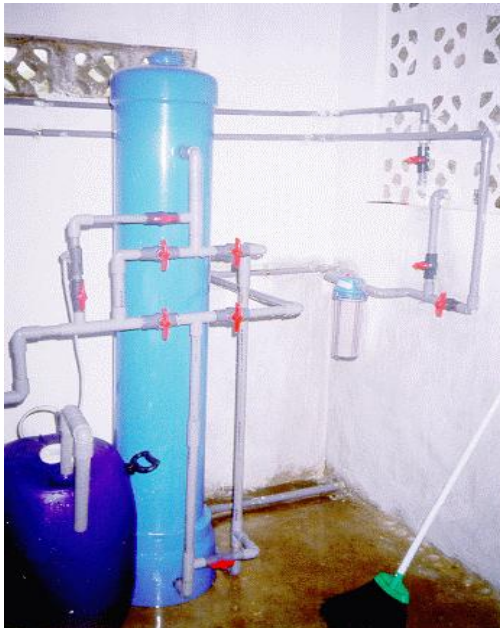
Gambar 7 : Unit peralatan penghilangan kesadahan dengan proses pertukaran ion.
