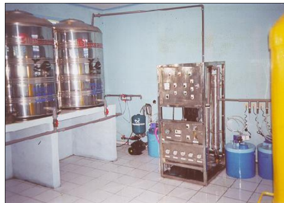
Gambar 13 : Pengolahan Air Sistem Reverse Osmosis 20 m 3 /hari.
