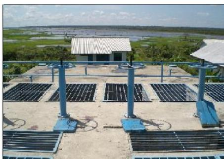
Gambar 2. Unit Flokulasi-Koagulasi dan Unit Pengendap PDAM Danau Teloko
