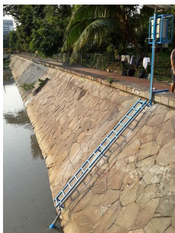
Gambar 11 : Hasil Pemasangan Akhir Bangunan Online Monitoring.
