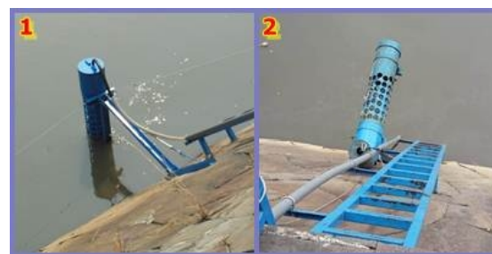
Gambar 13 : Hasil Pemasangan Struktur Pelampung.
