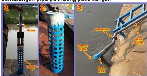
Gambar 10 : Perakitan Dan Pemasangan Pelindung Sensor.
