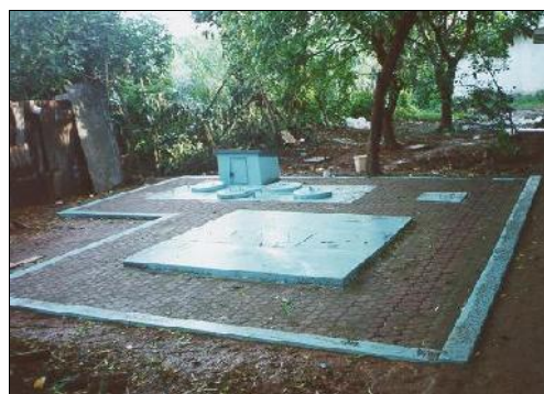
Gambar 8 : Unit alat pengolahan air limbah rumah sakit dengan sistem "Biofilter Anaerob-Aerob", kapasitas 15-20 m 3 per hari. Lokasi : Rumah Sakit Umum "MAKNA", Ciledug, Tangerang.
