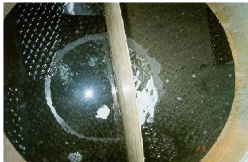
Gambar 5 : Lapisan mikroorganisme yang telah tumbuh dan menempel pada permukaan media biofilter.
