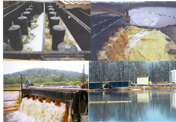
Gambar 13. Aplikasi Baffle Aerator Untuk Pengolahan Air Asam Tambang.
