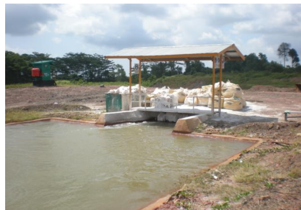
Gambar 4. Pembubuhan Kalsium Hidroksida Bubuk pada Air Asam Tambang Secara Manual.
