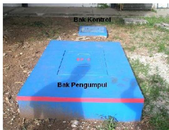
Gambar 11. Contoh Foto Bak Pengumpul Dan Bak Kontrol
