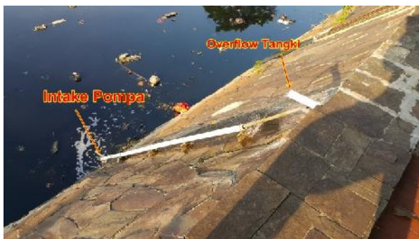
Gambar 11: Kondisi Intake Pompa dan Tangki Overflow Sistem Online Monitoring Segmen Istiqlal.
