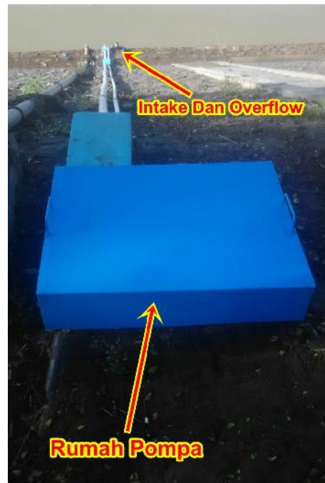
Gambar 17: Kondisi Pompa, Intake Pompa dan Tangki Overflow Sistem Online Monitoring Segmen Kelapa Dua.
