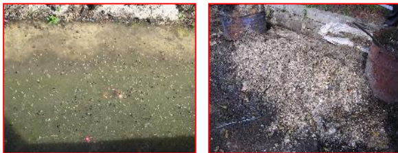
Gambar 3. : Saluran Air Yang Sangat Kotor Penuh Dengan Belatung Dan Tumpukkan Limbah Padat Di Sepanjang Jalan.
