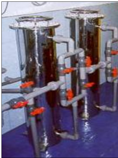
Gambar 6: Rangkaian Filter Multi Media Dan Karbon Aktif
