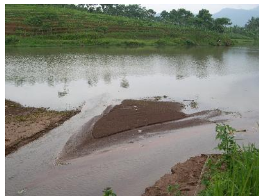
Gambar 10. Ceckdam disamping berfungsi untuk penangkap sedimen juga dapat berfungsi untuk penampung air hujan
