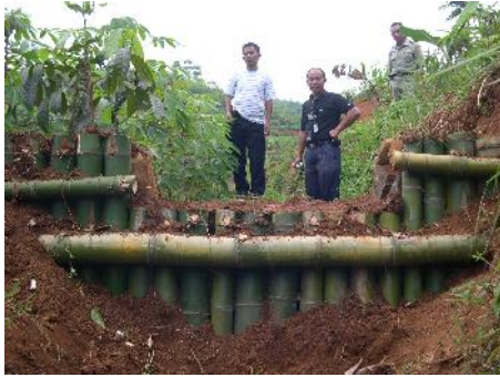
Gambar 13. Konstruksi jebakan sedimen ( sediment trap ) bioengineering dari bahan bambu (30 Januari 2007)
