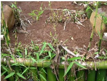
Gambar 14. Jebakan sedimen ( sediment trap ) bioengineering telah penuh dengan sedimen dan bambu telah nampak tumbuh (4 Maret 2007)
