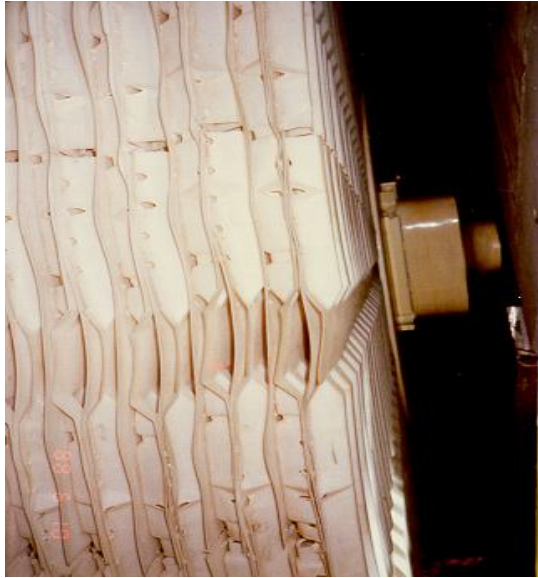
Gambar 6 : Modul media RBC yang telah terpasang.
