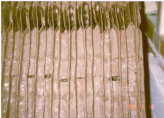
Gambar 7 : Lapisan mikro-organisme yang telah tumbuh dan melekat pada permukaan media RBC yang telah beroperasi.
