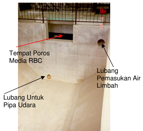
Gambar 5 : Bak Reaktor RBC sebelum di pasang media
