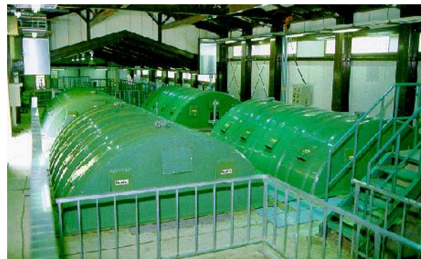
Gambar 10 : Salah satu contoh instalasi pengolahan air limbah dengan proses RBC, dengan tutup reaktor untuk menghindari pengaruh suhu dingin.
