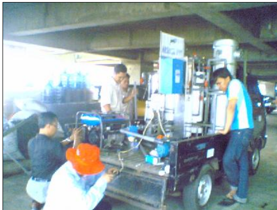
Saat Perakitan Unit Pengolah Air
