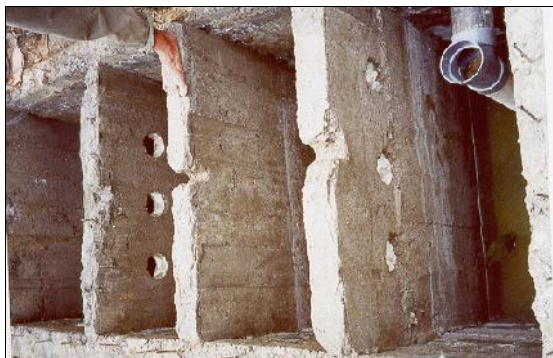
Gambar 14. Konstruksi dan bahan pembuatan IPAL dari beton cor
