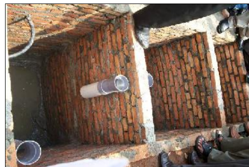
Gambar 13. Konstruksi dan bahan pembuatan IPAL dari batu bata
