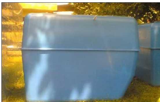
Gambar 15. Bahan pembuatan IPAL dari fiber glass
