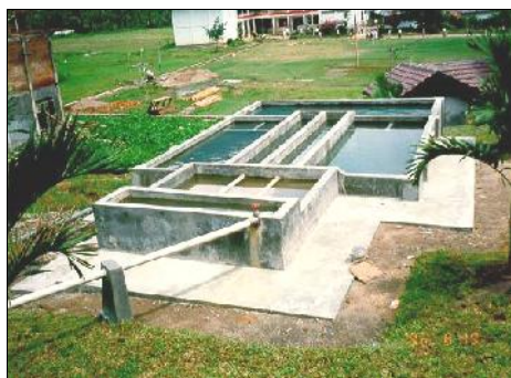
Gambar 6. Unit pengolahan air bersih saringan pasir lambat Up Flow , kapasitas 100 M 3 /hari. Lokasi : Pesantren La Tansa, Lebak, Jawa Barat.
