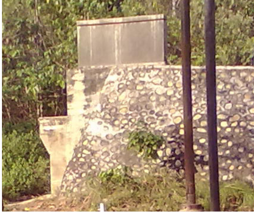
Gambar 4. Kondisi abutmen eksisting Jembatan Sumara
