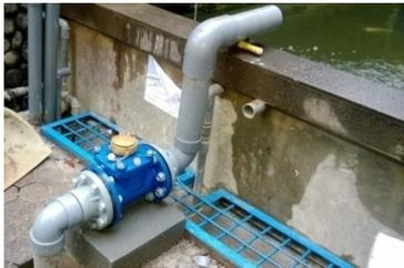
Gambar 9 : Foto Flow Meter untuk IPAL BPPT.
