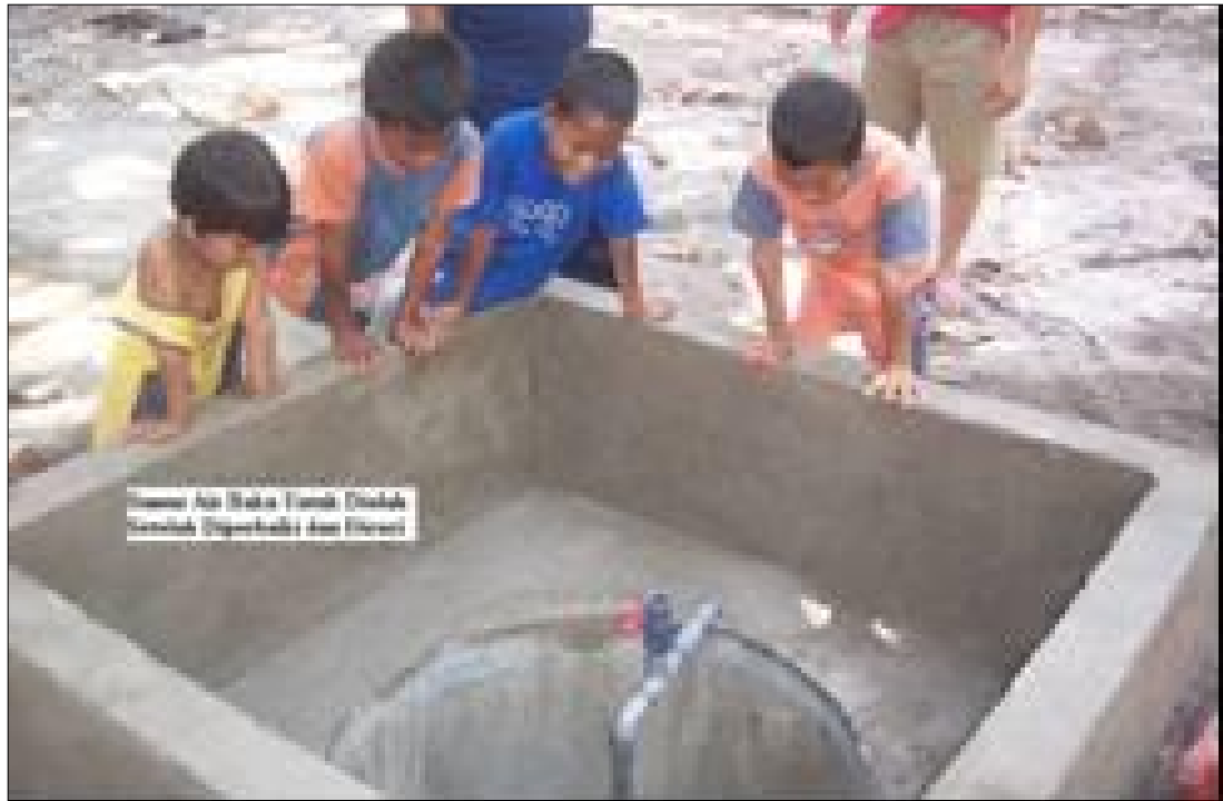
Foto 3 : Sumur air baku yang telah diperbaiki dan dibersihkan.
