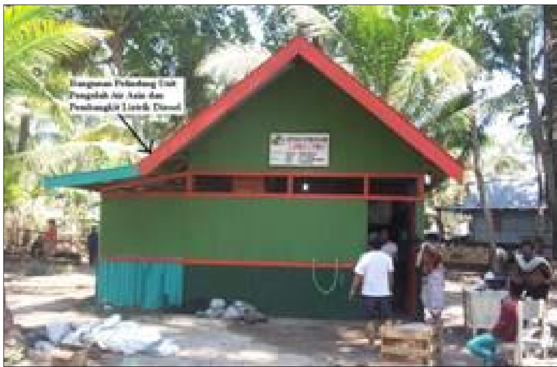
Foto 2 : Bangunan pelindung instalasi diesel pulau pandangan yang diperlebar oleh masyarakat sebagai tempat pengolah air asin.
