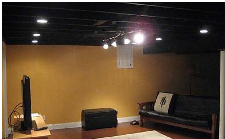
Gambar 3. Ilustrasi penggunaan track lighting pada ceiling yang gelap di sebuah ruangan. (sumber : internet)
