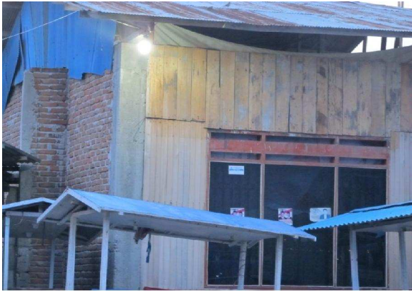
Gambar 9. Salah satu rumah dengan material batu bata dan kayu di Teluk Palu
