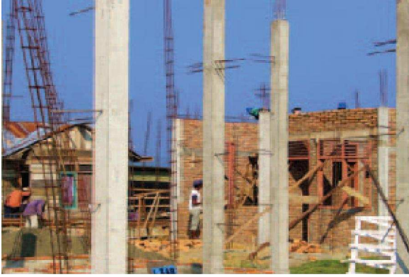
Gambar 12. Kolom dirancang terikat dengan dinding pada rumah tahan gempa
