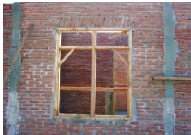
Gambar 8. Rumah bata yang tidak sesuai untuk rumah tahan gempa dan tsunami
