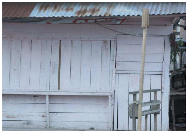
Gambar 11. Kayu berkadar air tinggi yang digunakan sebagai bahan bangunan
