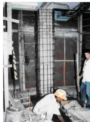
Gambar 18. Perkuatan dengan metode Concrete Jacketing (sumber: Sunaryo, dkk, 2009)
