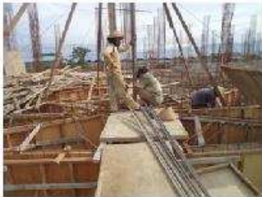
**Gambar 7.** Pengecoran rib
