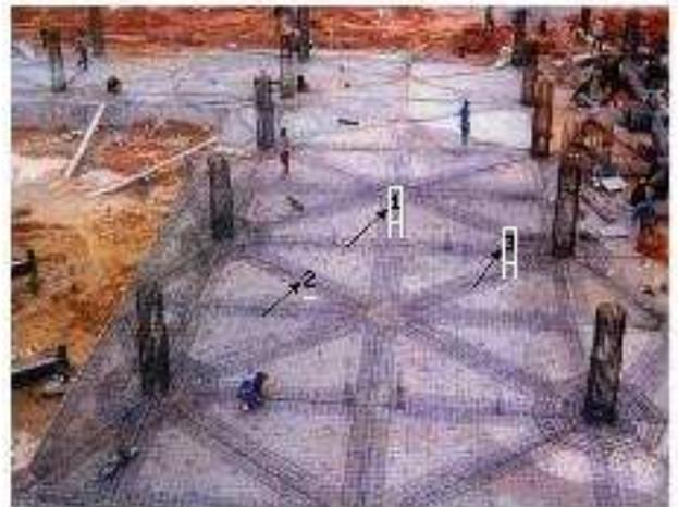
**Gambar 1.** Konstruksi sarang laba-laba
