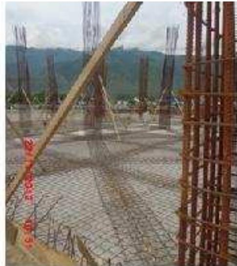
**Gambar 9.** Pemasangan pembesian slab
