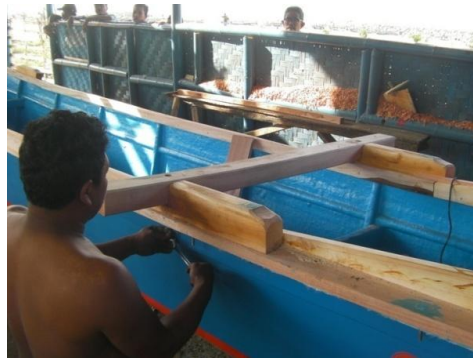
Gambar 8 Pemasangan sheer dan tempat baruyungan
