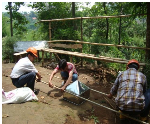
Gambar 1. Persiapan penyambungan pipa pada corong stainless steel
