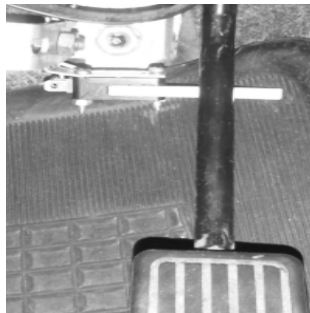
Gambar 11. Limit di tuas gas
