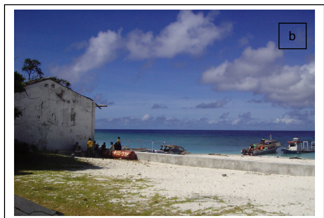
Foto 2. a. Pantai Berpasir di Pantai Racuna, berpasir putih, relief 2° - 5°; b. Sea Wall sebagai pelindung Pantai Racuna
