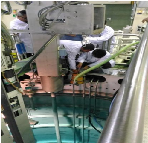
Gambar 1. Pemasangan pompa benam.
