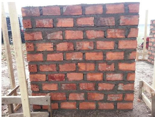
Untuk pekerjaan pemasangan dinding bata merah seluas 1 m<sup>2</sup>, kebutuhan bahan tergantung dari tebal pemasangannya. Pasangan bata merah tebal 1 batu artinya dinding seluas 1 m<sup>2</sup> dipasang bata merah setebal ukuran panjangnya, yakni 22 cm. Koefisien campuran Semen Portlan (SP) dan Pasir Pasang (PP) dinayakan dalam perbandingan volume. Sehingga untuk Analisa Pemasangan 1m<sup>2</sup> dinding bata merah (5x11x22)cm menurut AHSP 2013 adalah sebagai berikut:
