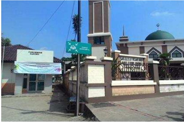
Gambar 18. Salah satu tempat evakuasi longsor di pelataran masjid
