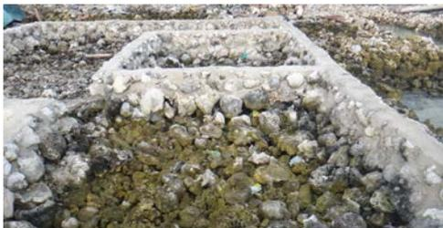
Gambar 3. Pondasi dengan terumbu karang
