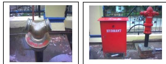
Gambar 5: Hidran di Luar Gedung dengan Siamese connection
