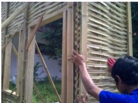
Gambar 10. Penyetelan konstruksi rangka dinding
