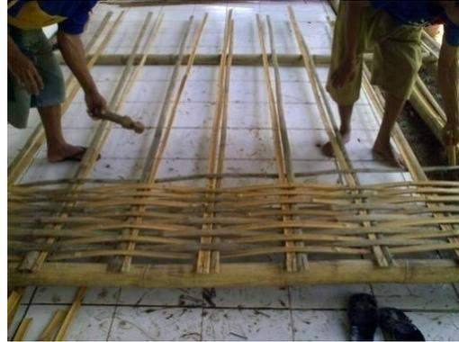
Gambar 8. Cara menganyam rangka dinding bambu (Dokumentasi Kegiatan, 2010)
