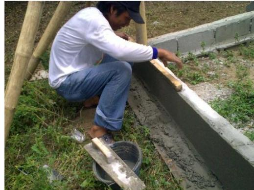
Gambar 11. Penyetelan dinding Peralihan/dinding dasar
