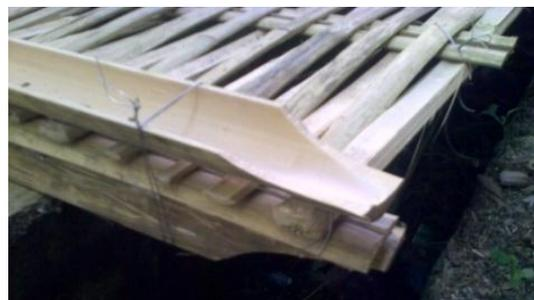
Gambar. 9. Pembuatan merakit modul anyaman dinding bambu (Dokumentasi Kegiatan, 2010)
