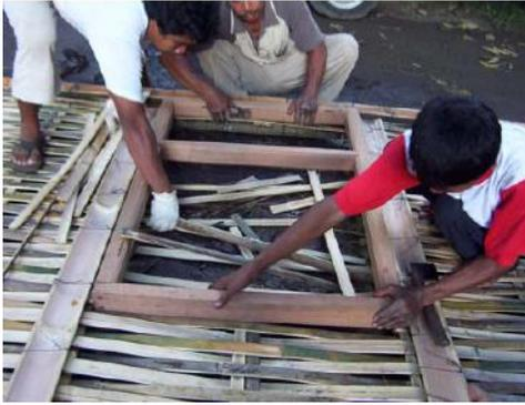
Gambar 8. Pemasangan kosen jendela pada rangka dinding bambu
