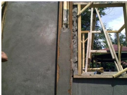
Gambar 14. Plesteran kolom, menggunakan papan bekisting agar hasil yang rapi dan lurus (Dokumentasi Kegiatan, 2010)
