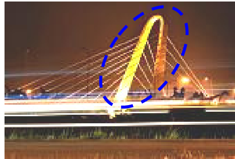
Gambar 1. Aplikasi SCC pada Menara Jembatan Grand Wisata di Bekasi
