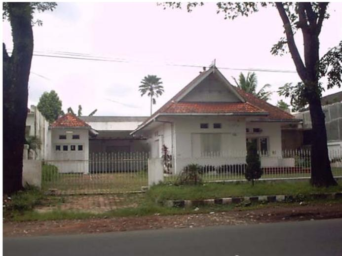
Gambar 2. Salah satu berukuran kecil dengan bentuk atap limasan dan bagian gevel menggunakan bilah papan.
