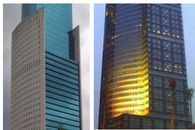
Gambar 17. Fasad Badan Gedung tipikal minimalis di jalan Jendral Sudirman Sumber: Survey, 2009
