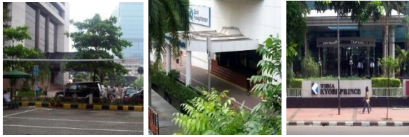
Gambar 12. Kanopi struktur beton atap polycarbonate; skylight Sumber: Survey, 2009.
