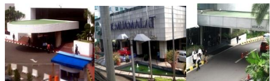
Gambar 11. Kanopi massif struktur beton bertulang
