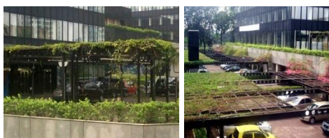
Gambar 14. Kanopi para-para vegetasi pada lobby dan area parkir Sumber: Survei 2009.
