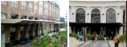
Gambar 13. Kanopi precast komposit ringan, kabel baja Sumber: Survey, 2009.
