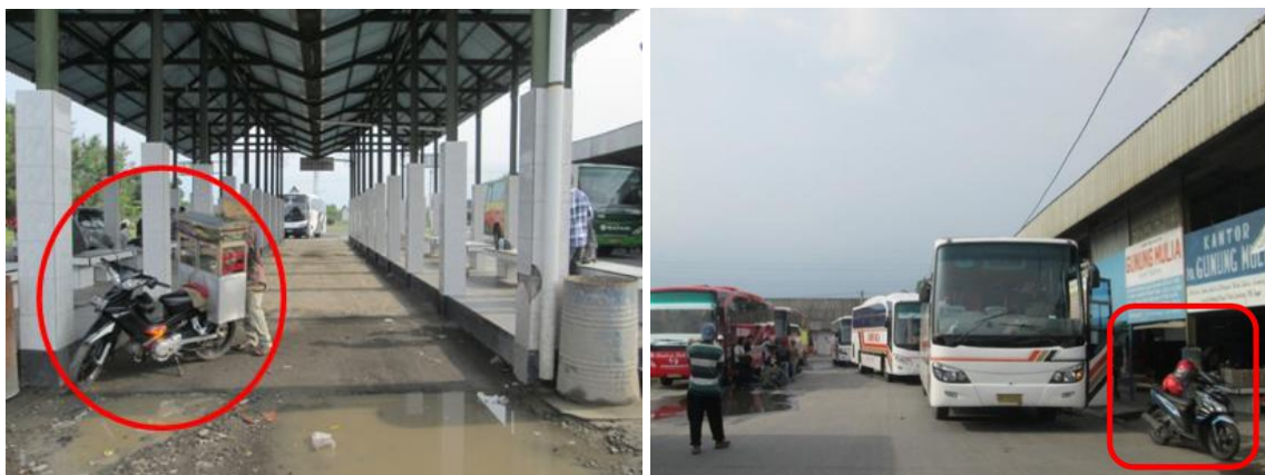
Gambar 2. Parkir tidak tertata Sumber : Dokumen penulis, 2013
