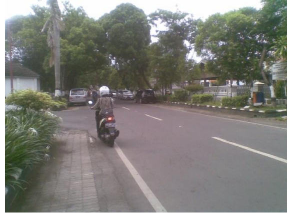
Gambar 16. Kondisi Fisik Jalan Lokal di Jalan Veteran Sumber: Survei, 2013
