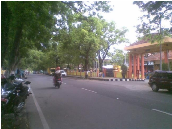
Gambar 14. Kondisi Fisik Jalan Kolektor di Jalan Setiabudi Sumber: Survei, 2013
