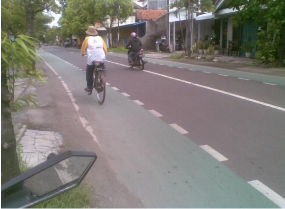
Gambar 13. Kondisi Fisik Jalan Kolektor di Jalan Jenderal Ahmad Yani Sumber: Survei, 2013
