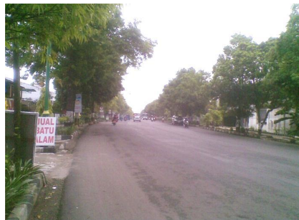
Gambar 12. Kondisi Fisik Jalan Raya (Arteri) Sukowati Segmen Barat Sumber: Survei, 2013
