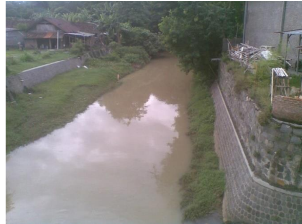
Gambar 22. Kondisi Fisik Sungai Garuda yang Bertanggul Sumber: Survei, 2013
