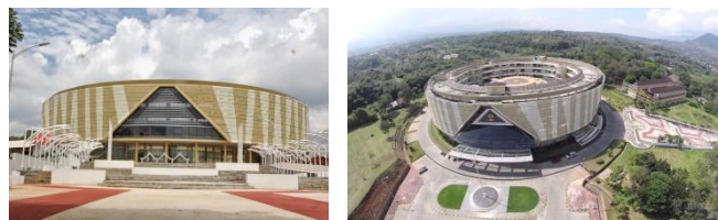
Gambar 1.1 Eksterior Gedung Rektorat UNPAD Jatinangor 2
