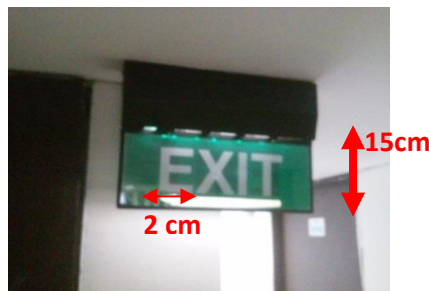
Gbr. 16 Besar Signage "exit" pada Bangunan Apartemen X Sumber : Foto Survey (30/10/15)
