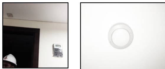
Gambar 11 - Sprinkler pada koridor apartemen dan sprinkler pada basement
