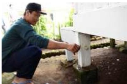
*Gambar 3.10 Pemberian minyak tanah pada kolom kayu untuk menghindari serangan rayap
