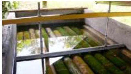
*Gambar 3.4 Cara pengawetan bambu dengan cara perendaman*
