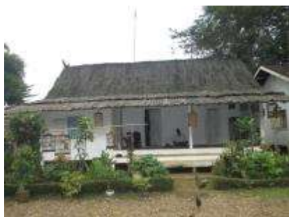
Gambar 1.1 Rumah Adat Kampung Pulo Sumber : Hasil Survey Lapangan 27/03/2014
