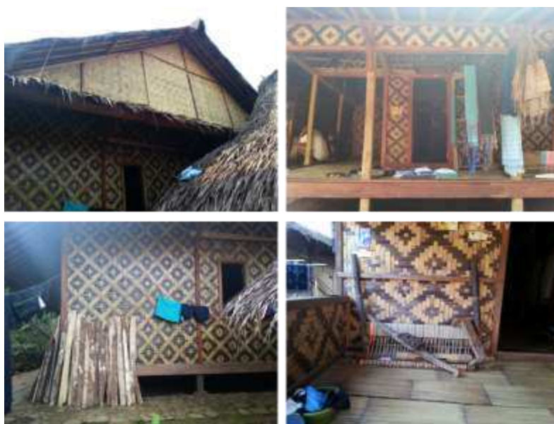
Gambar 10. Bilik kembang pada bangunan Kampung Ciboleger
