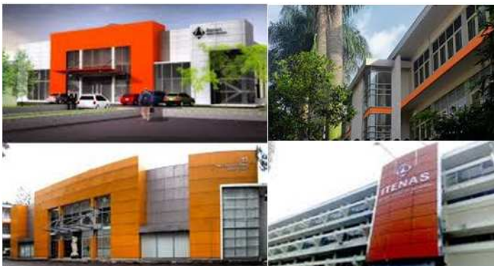
Gambar 2. Eksisting bangunan ITENAS
