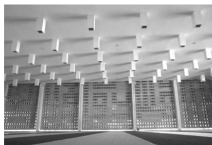
Gambar 11. Plafond Bangunan. (Sumber: Survey Lapangan)
